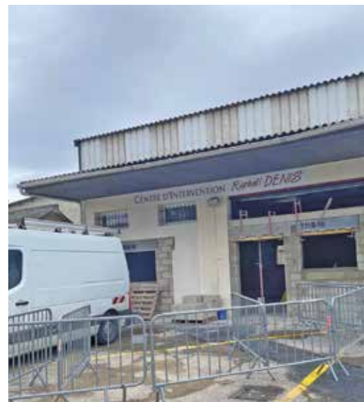
Travaux express : la caserne s'est transformée en cabinet médical en 3 mois !
